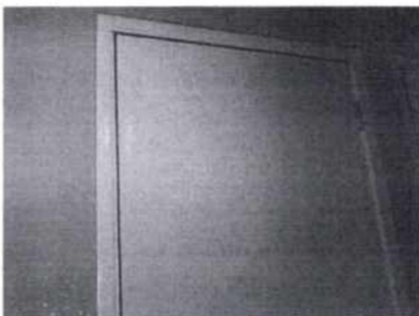
Foto 3. Bij de meterkasten ontbreekt de ventilatieopening aan de bovenkant. Foto 4. Vochtplekken op de muur.
