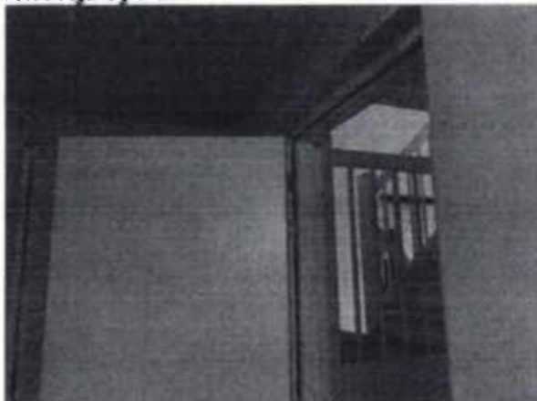
Foto 1. De toegangsdeuren van de appartementen en bergingen zijn niet brandwerend. Foto 2. Deze buis loopt door een brandscheiding.
