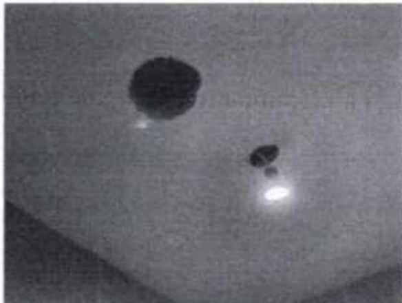
Foto 1. De toegangsdeuren van de appartementen en bergingen zijn niet brandwerend. Foto 2. Deze buis loopt door een brandscheiding.
