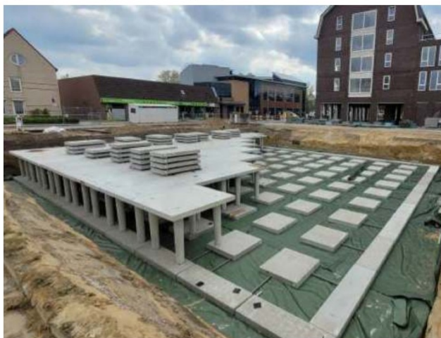
Figuur: Aanleg waterberging betonelementen (bron: Trewatin)
