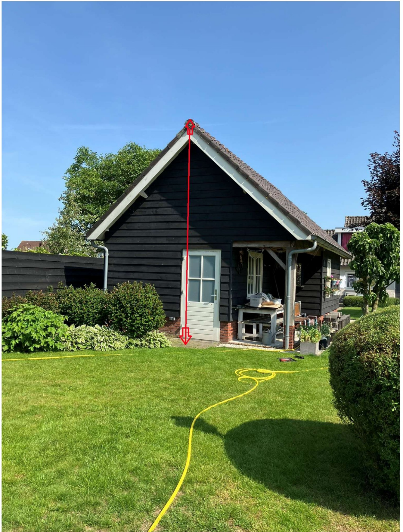
12) Aanzicht achtergevel bijgebouw en positie meetpunt 2
