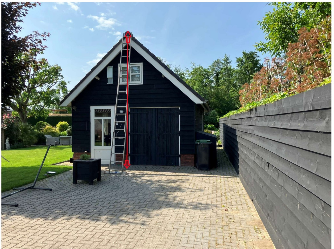
3) Aanzicht voorgevel bijgebouw met positie meting 1
