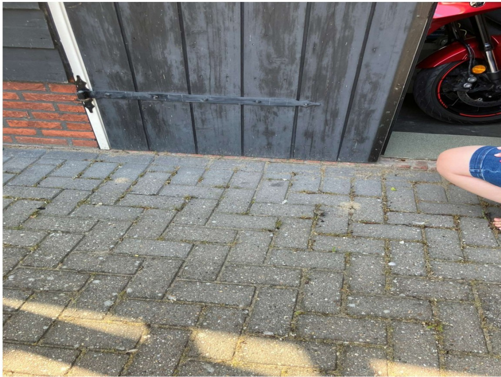
10) Aansluitend maaiveld (verharding) voorgevel bijgebouw
